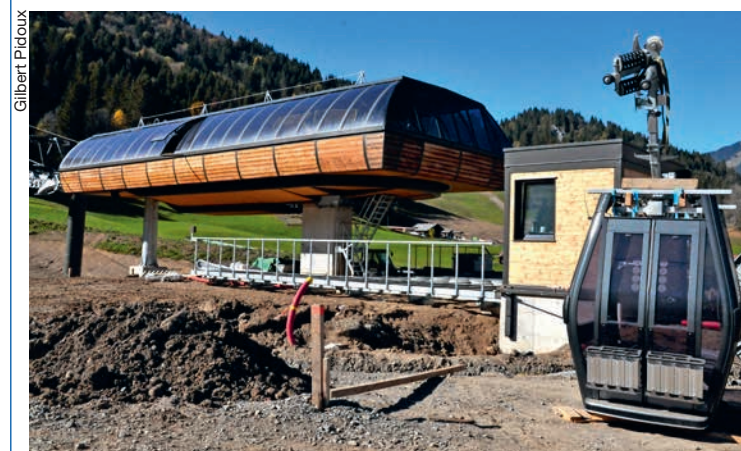
Le départ est sous toit. Des cabines à 10 places sont déjà là.
