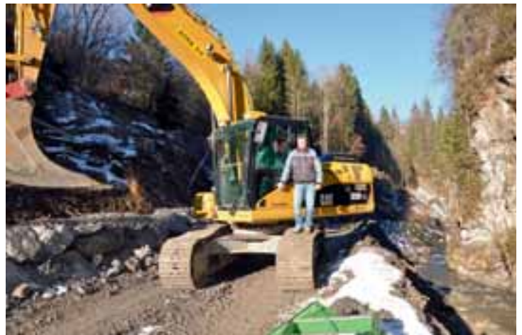
Aujourd'hui, des engins de chantier évoluent dans une gorge naguère inaccessible.
