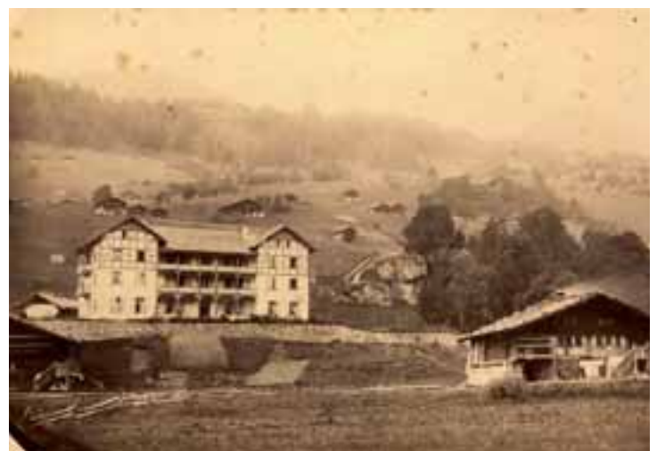
L'Hôtel des Diablerets, vers 1865, dans son état d'origine avec son toit en anseilles et ses magnifiques galeries en bois. Photos André Schmid, collection du Musée de l'Elysée.
