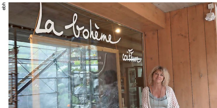
Vivement la fin des échafaudages!
