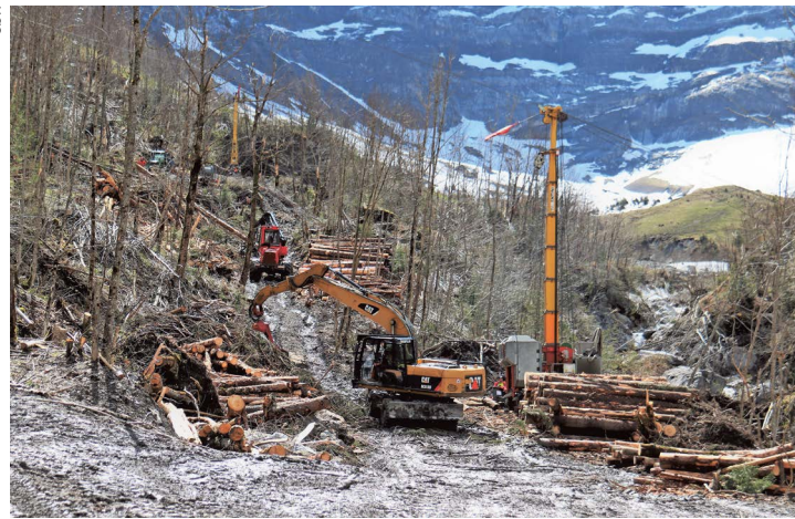
Un chantier unique et très impressionnant.
