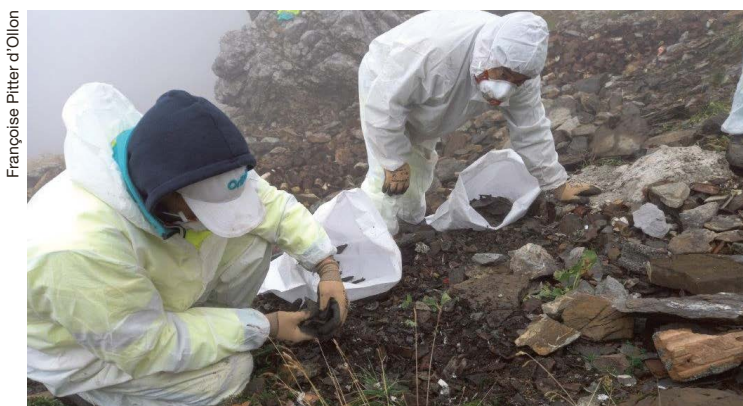
Les spécialistes collectent les plaques contenant de l'amiante.
