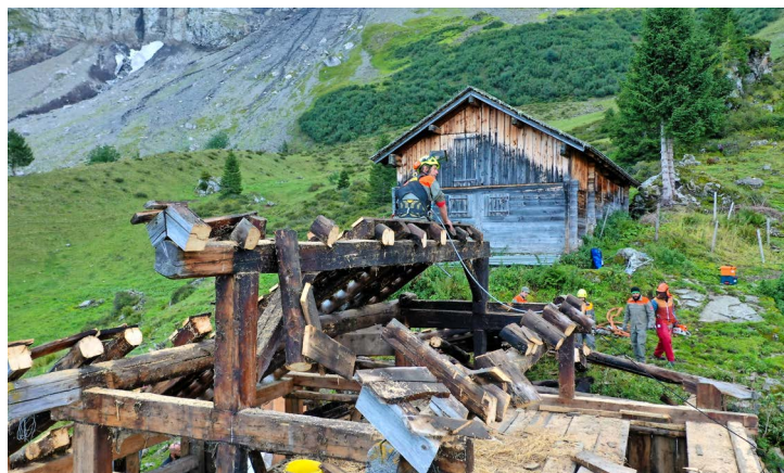
Démolition du chalet à Orgevaux.
