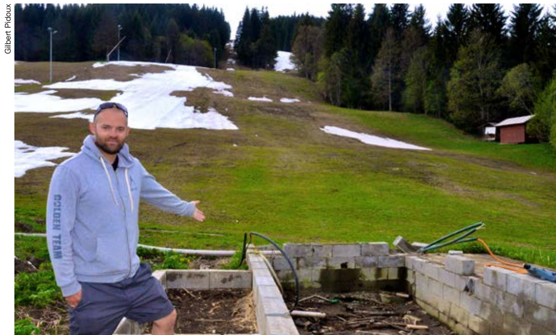
Simon Rouèche devant la cabane démolie du départ du téléski de la Jorasse, lui aussi démonté.
