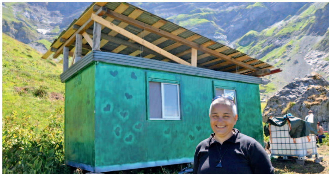
La cabane de Christiane est un conteneur amené par hélicoptère. Le toit recueille l'eau.
