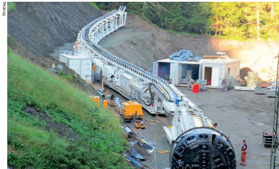
L'impressionnant tunnelier qui a percé la galerie de 5 km de longueur et de 3,6 m de diamètre.
