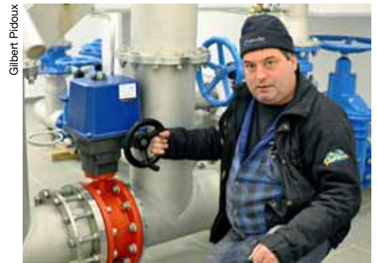
A. Rossier dans les entrailles du réservoir.
