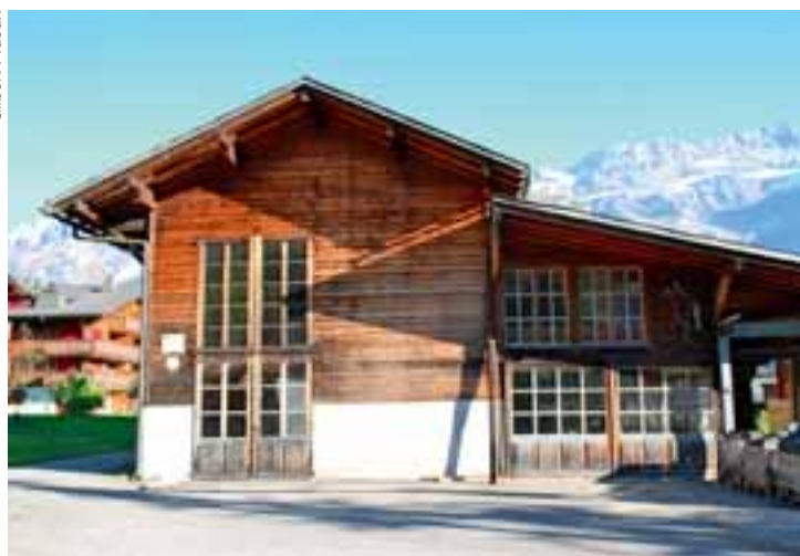
La menuiserie Perreten où s'érigera le cabinet de groupe.
