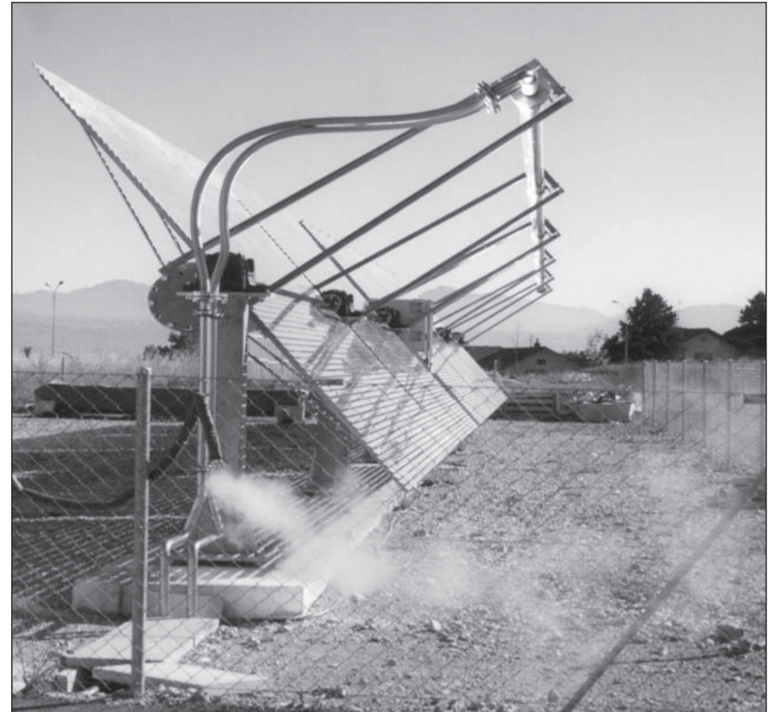
Grâce à la fondation SunAlpes, la première centrale de production d'énergie solaire dans les Alpes verra le jour à Isenau.
